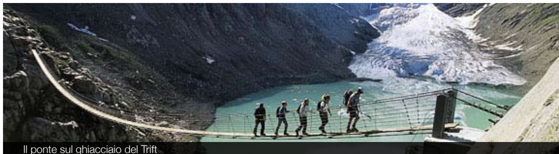
Il ponte sul ghiacciaio del Trift
